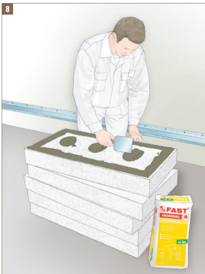
Obr. 8 Způsob nanášení lepicí malty na termoizolační desky
