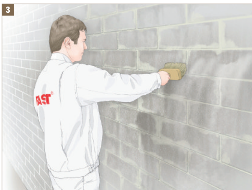
Obr. 3 Penetrace savých, pórovitých podkladů
