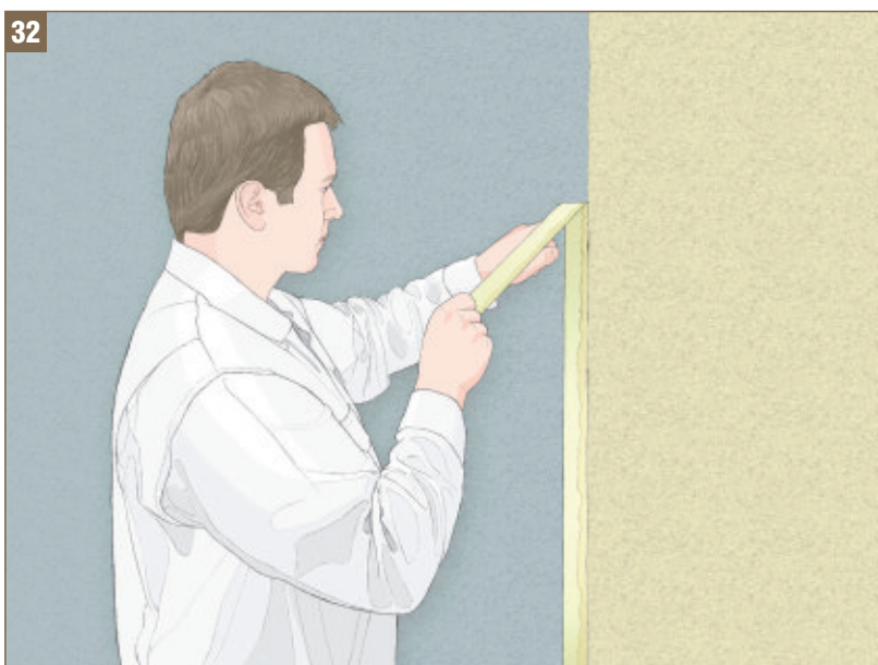
Obr. 32 Spojování různých barevných kombinací na jedné stěně.
