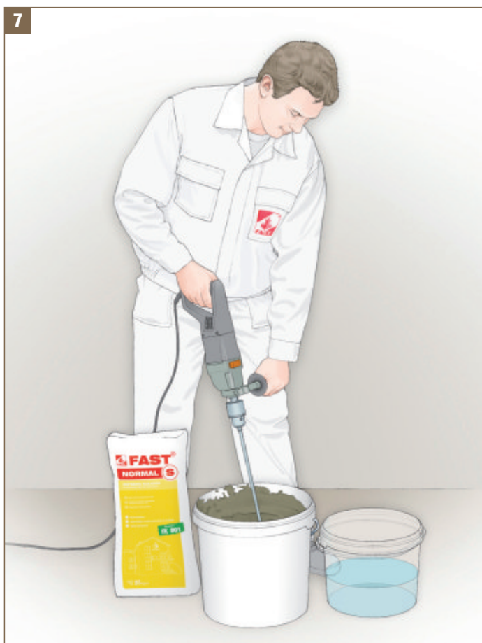
Obr. 7 Příprava lepicí malty
