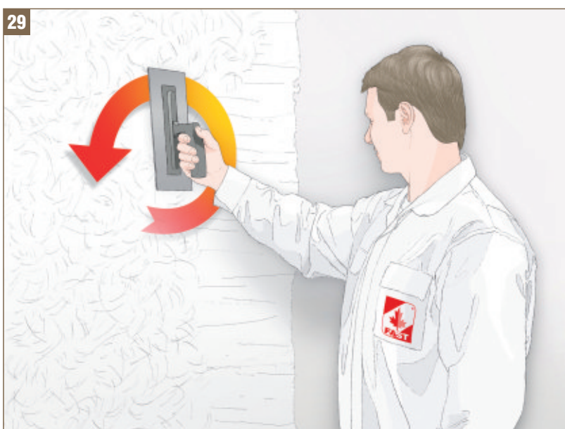
Obr. 29 - Konečná úprava omítky (kruhové rýhy)
