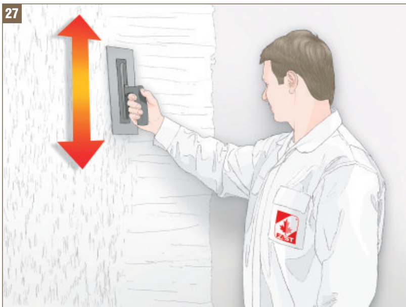
Obr. 27 Konečná úprava omítky (svislé rýhy)
