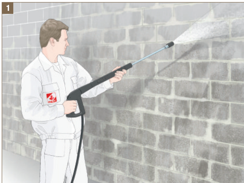
Obr. 1 Umývání zdi tlakovou vodou
