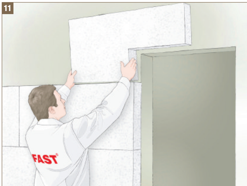
Obr. 11 Správné uložení termoizolačních desek kolem oken a dveří
