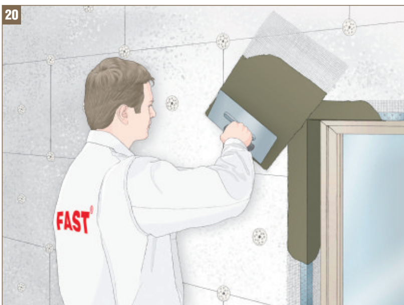
Obr. 20 Zesílení rohu kolem okenních a dveřních ostění
