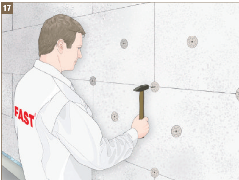
Obr. 17 Montáž hmoždinek a přibíjení kolíků
