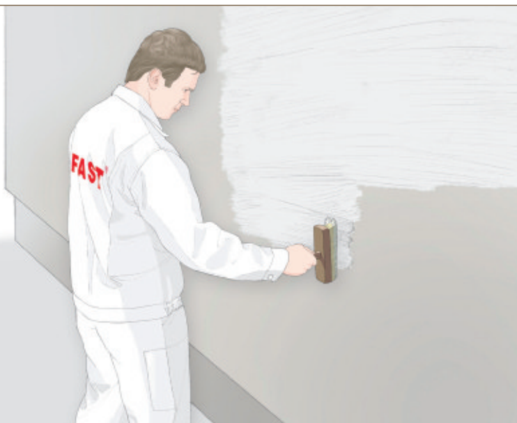
Obr. 23 Nanášení penetračního podkladového prostředku
