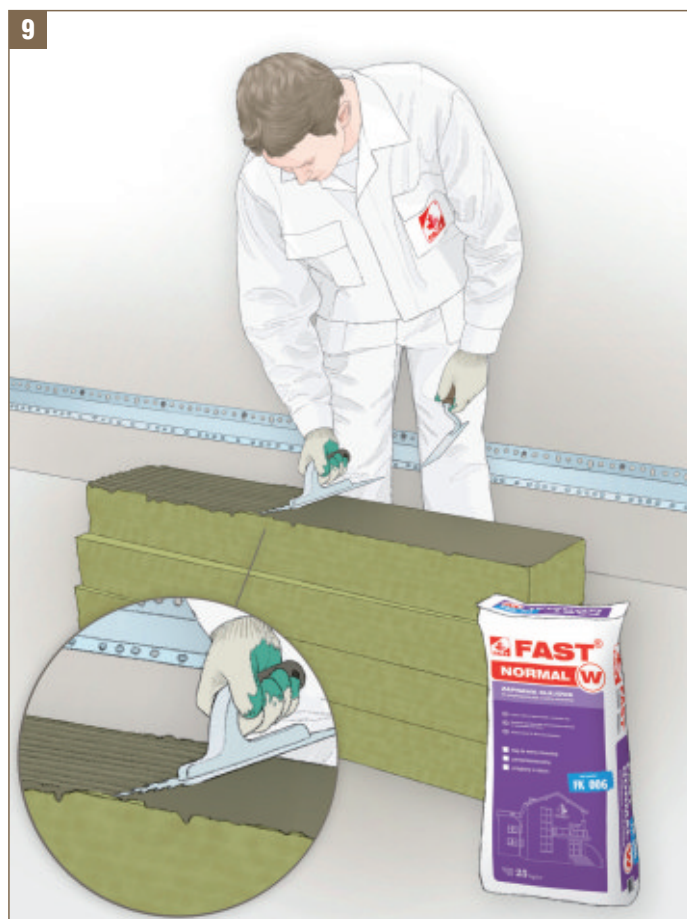
Obr. 9 Nanášení lepicí malty na desky z minerální vlny (lamely)
