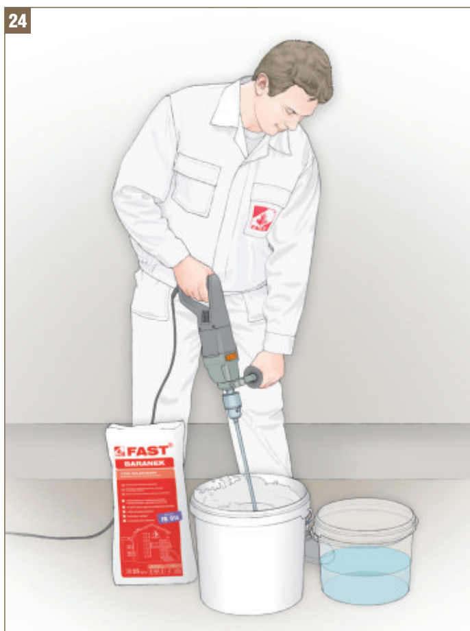
Obr. 24 Příprava omítkové směsi před nanesením (polymerové a minerální omítky) © FAST 2008
