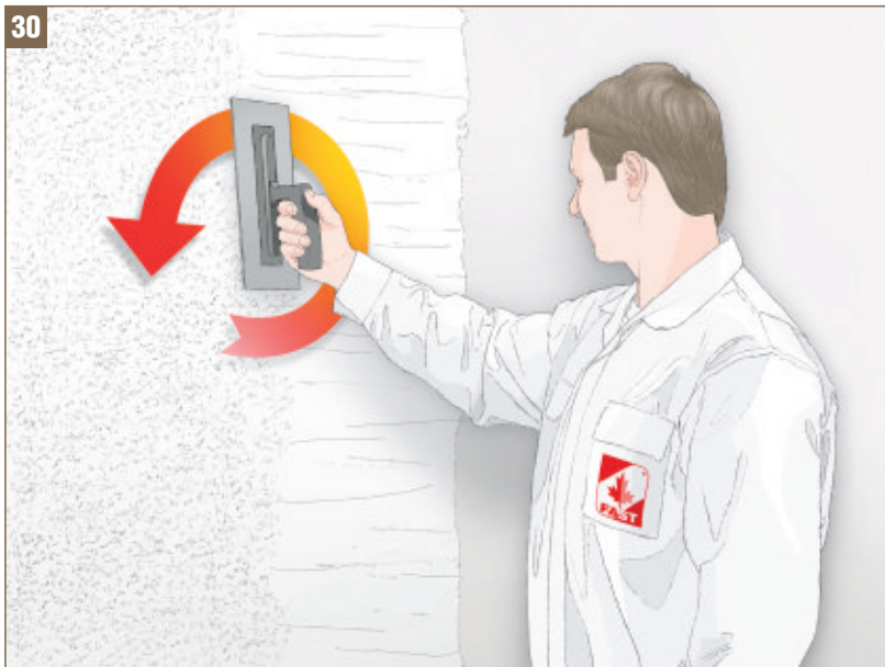
Obr. 30 Konečná úprava omítky kruhové pohyby
