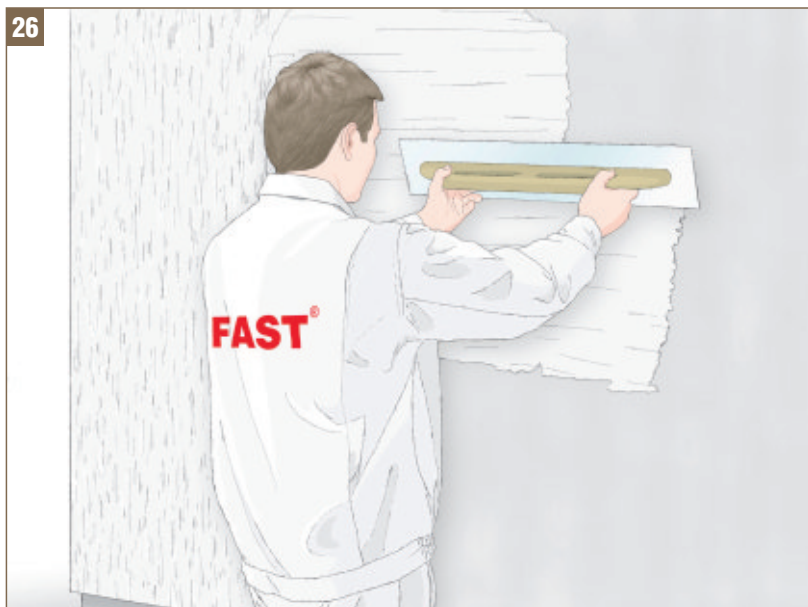
Obr. 26 Nanášení omítkové směsi na připravenou zeď
