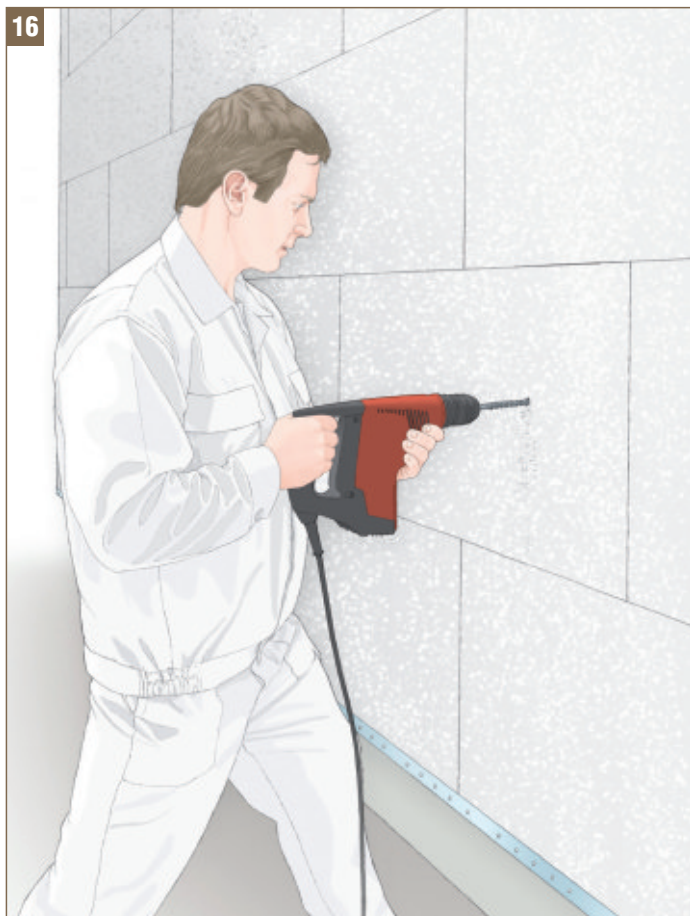
Obr. 16 Navrtání otvorů pro hmoždinky
