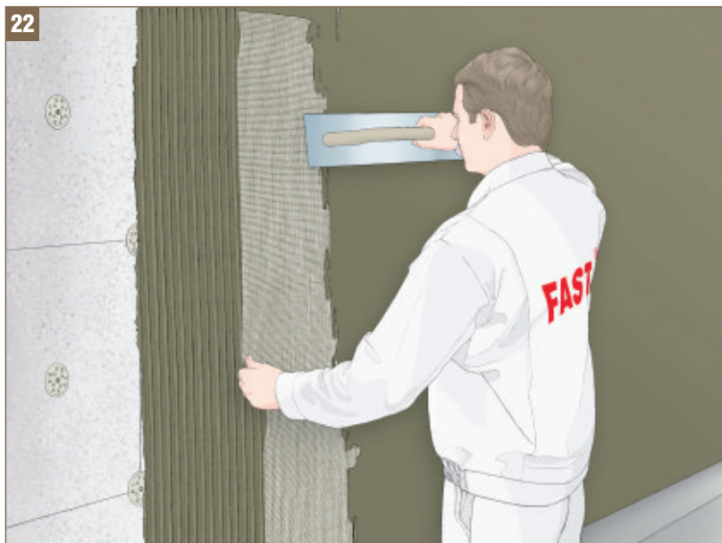
Obr. 22 Ponořování mřížky do vrstvy lepicí malty
