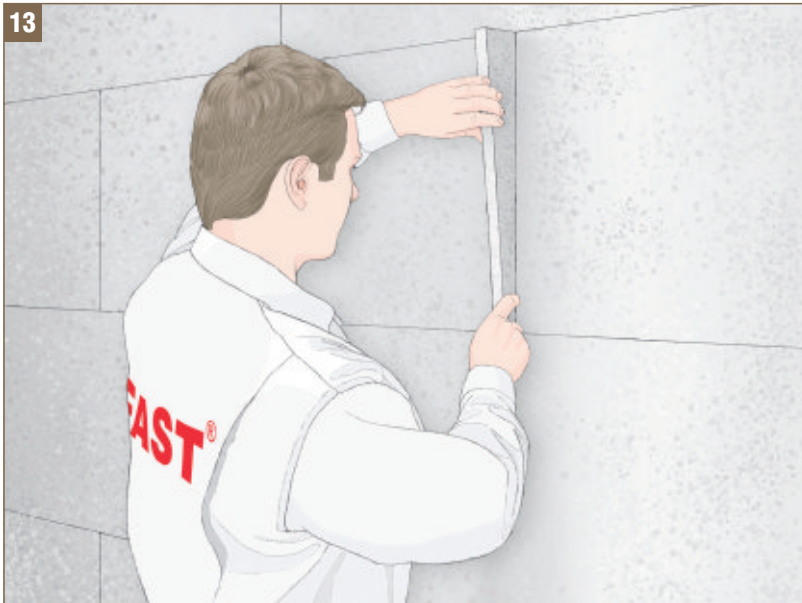
Obr. 13 Vyplnění spár mezi deskami pomocí pásky termoizolačního materiálu
