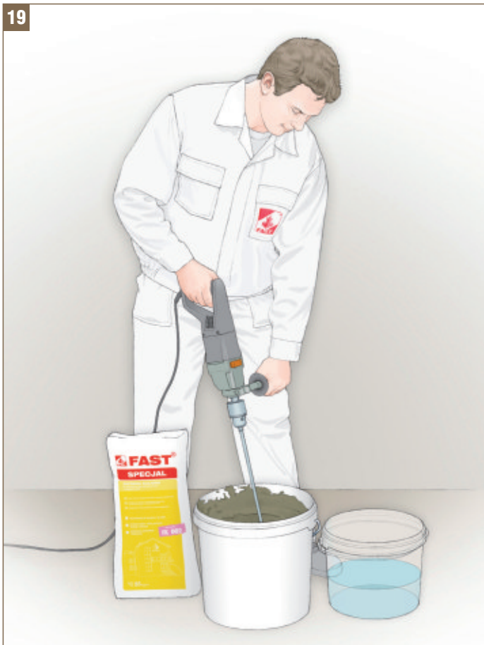
Obr. 19 Příprava lepicí malty FAST SPECJAL
