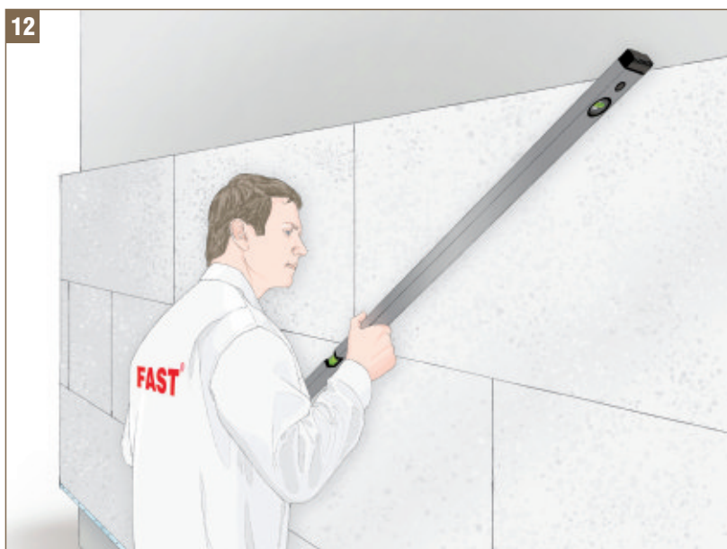
Obr. 12 Kontrola plochy desek po přilepení
