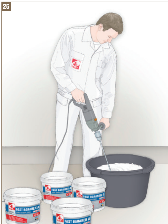
Obr. 25 Příprava omítkové směsi před nanesením (akrylové, silikátové a siloxanové omítky)
